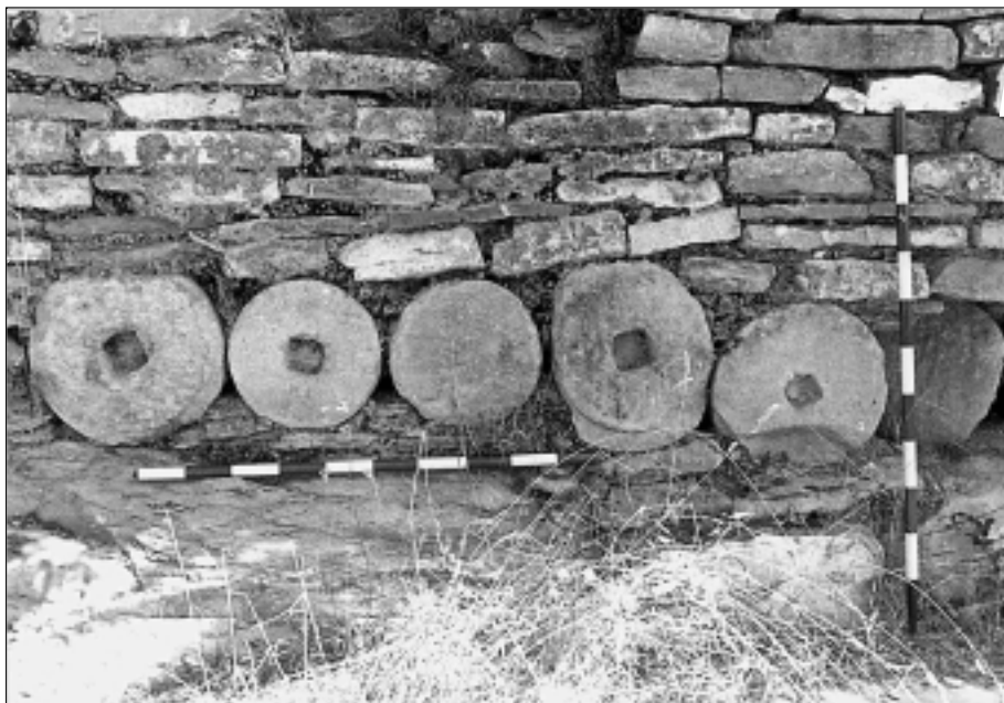
Fot. 16. Tambores de columnas en el lienzo entre las torres XII y XIII. El primero y el tercero, por la izquierda, son basas.
