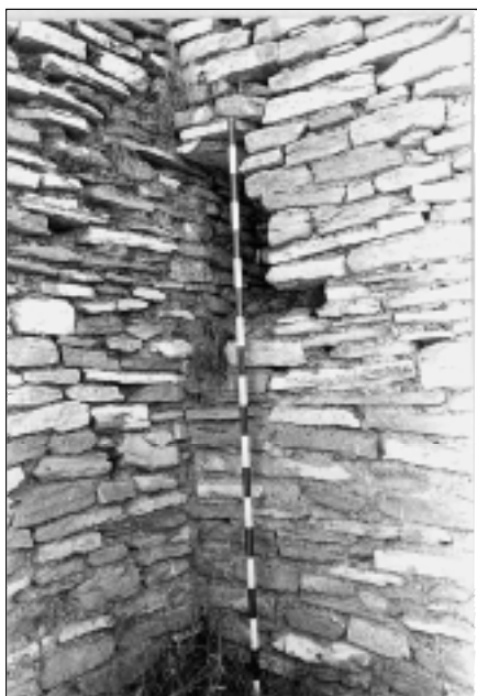
Fot. 17. Yuxtaposición del lienzo de la muralla a la cara Sur de la torre XVI (Edificio público nº 1).
