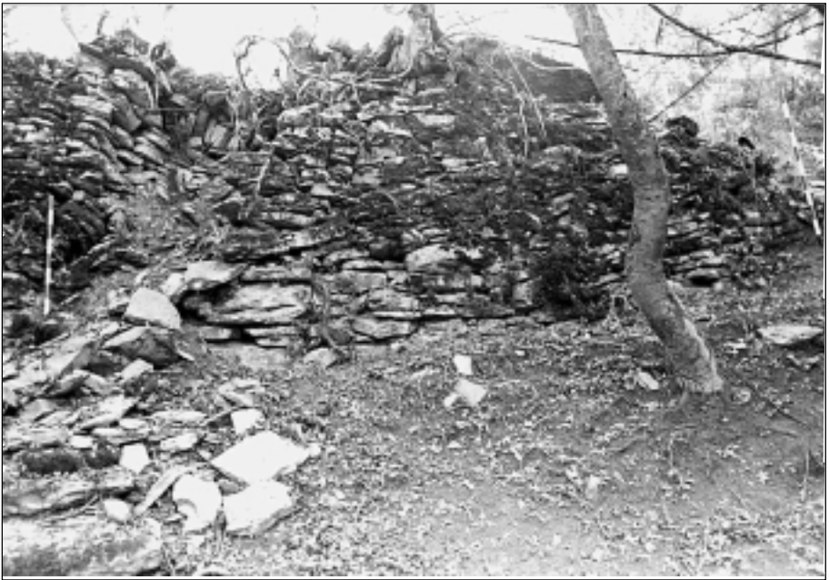
Fot. 19. Torre de flanqueo de la Puerta Norte.
