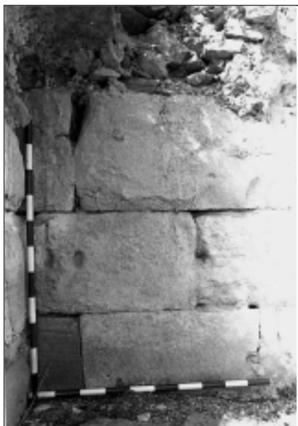
Fot. 9. Sillares con cajas para grapas, reutilizados junto a la esquina Este de la torre VIII.
