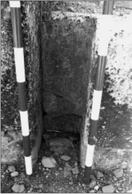
Fot. 4. Estriado vertical producido por el deslizamiento del rastrillo en la ranura Oeste de la Puerta Sur.
