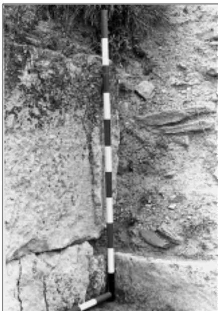
Fot. 8. Saliente tallado en el primer sillar de lienzo, para recibir la torre VI.
