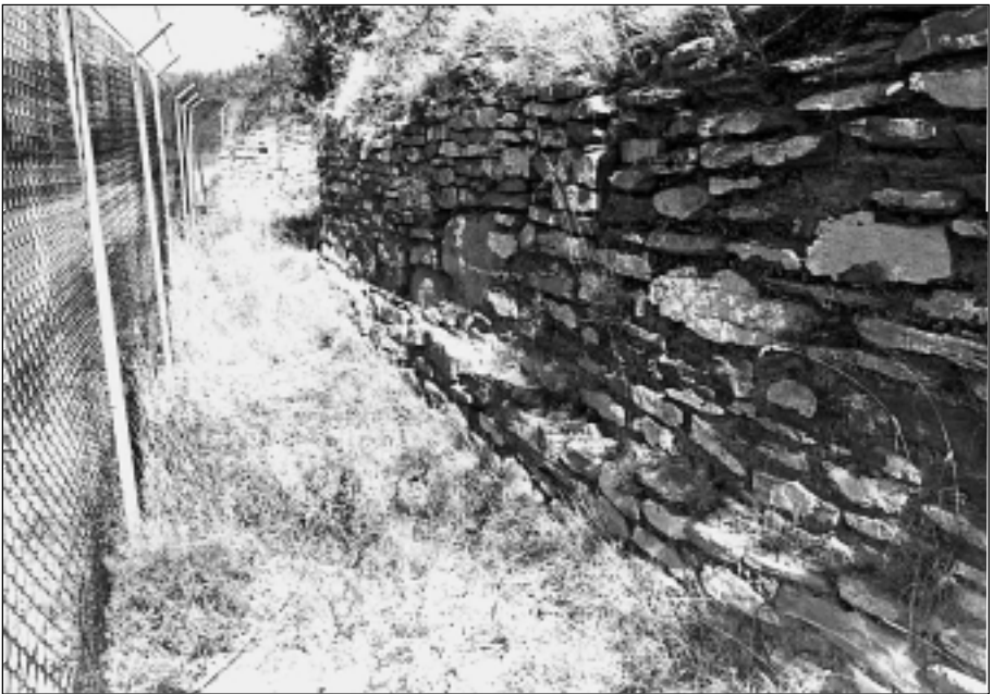
Fot. 11. Banqueta de cimentación del lienzo entre la torre IX y la Poterna.
