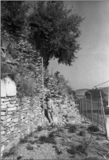
Fot. 10. Vista del relleno de la muralla conservado en la torre VIII.
