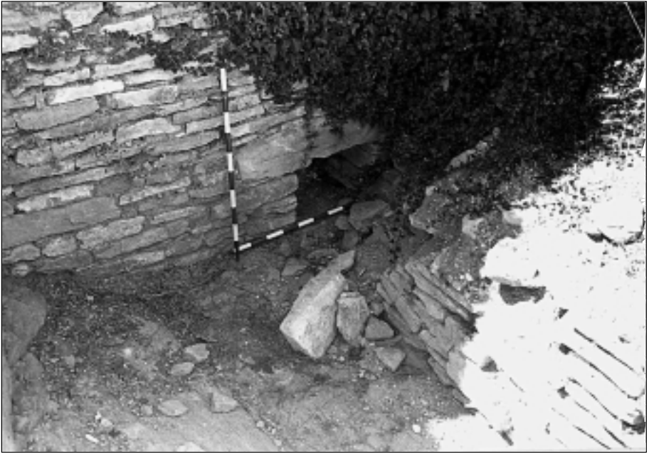
Fot. 18. Lienzo de muralla al Norte del Edificio público nº 1, bloqueando la entrada del canal.
