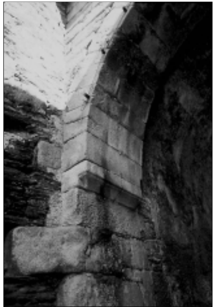
Fot. 24. Lugo. Puerta de Santiago. Moldura en el arranque izquierdo del arco exterior.
