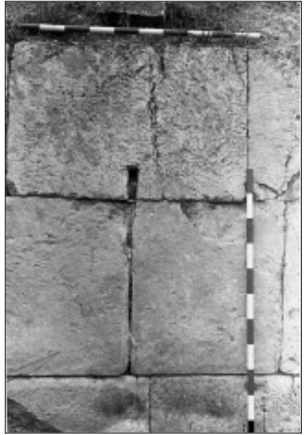
Fot. 6. Sillar con caja para grapa, reutilizado en el lienzo entre las torres VI y VII.
