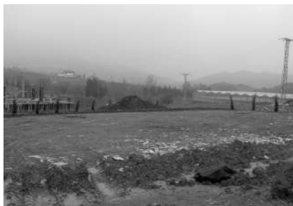
Vista general de la remoción de tierra en Mentxakabekoa.
