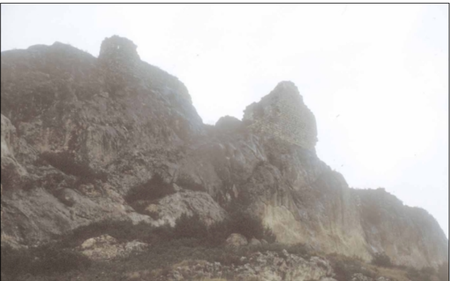
7. Portilla (Álava). En esta perspectiva desde el Sur se aprecia cómo la construcción se adapta a la roca, indudablemente acondicionada para mejorar su defensa. Son visibles las aspilleras de una de sus torres y el importante trabajo de cantería desarrollado en su construcción.
