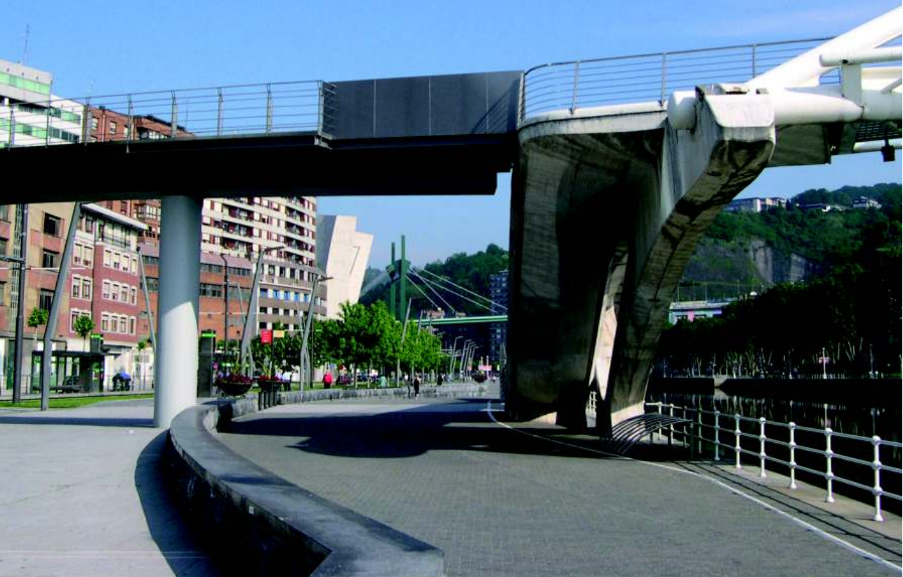
Fot. 12. Vista desde el Paseo de Uribitarte. Los tramos de barandilla ciega que marcan el final de la pasarela proyectada por el Sr. Isozaki han de valorarse como tímidos. Foto: Enrique Carvajal Salinas
