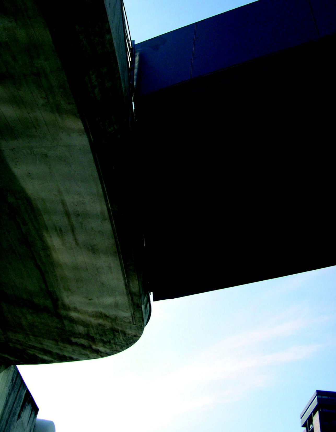
Fot. 14. Entre ambas pasarelas media una junta. Foto: Enrique Carvajal Salinas
