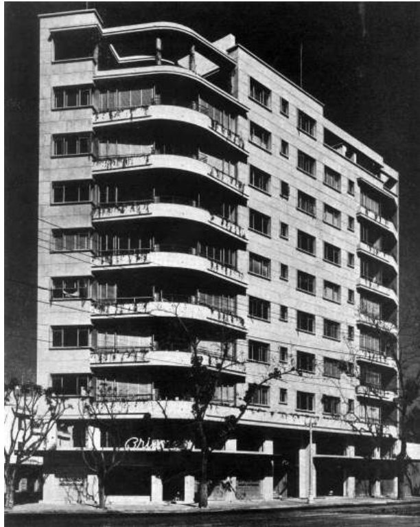
Juan de Madariaga. Edificio en la glorieta de Chilpancingo, Av. Insurgentes, México D.F., 1948. Tomado de la revista Arquitectura-México , num. 25, junio de 1948
