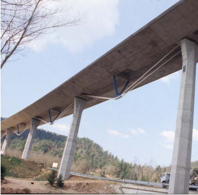
Viaducto de Osormort
