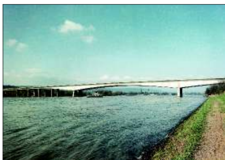
Puente de Bendorf
