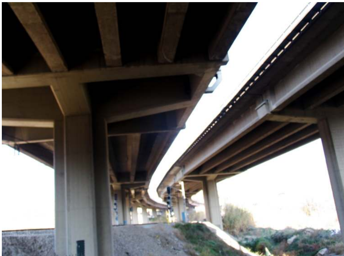
Puente de Torre Baró
