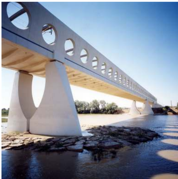
Puente sobre el río Ebro L.A.V.
