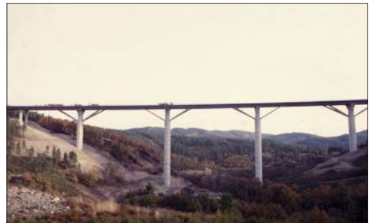
Puente sobre el río Mente
