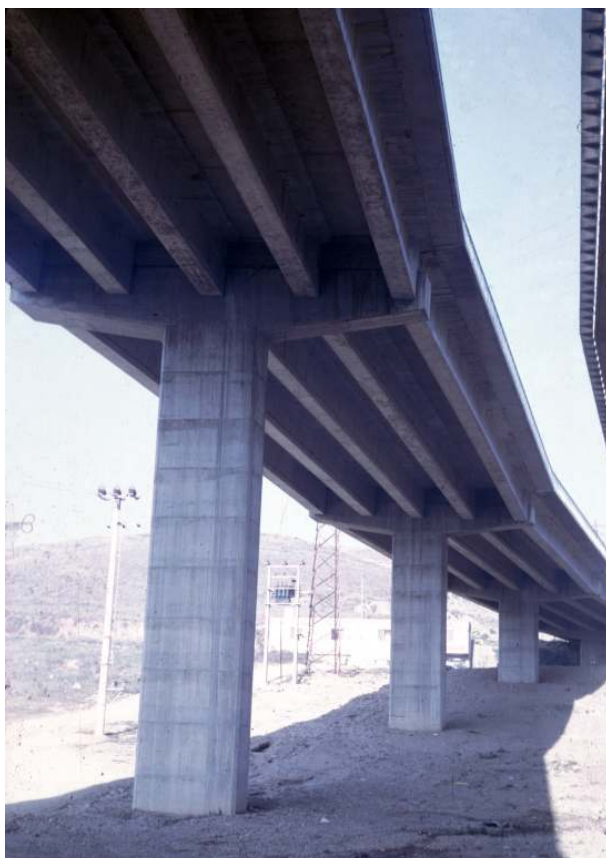
Puente de Torre Baró
