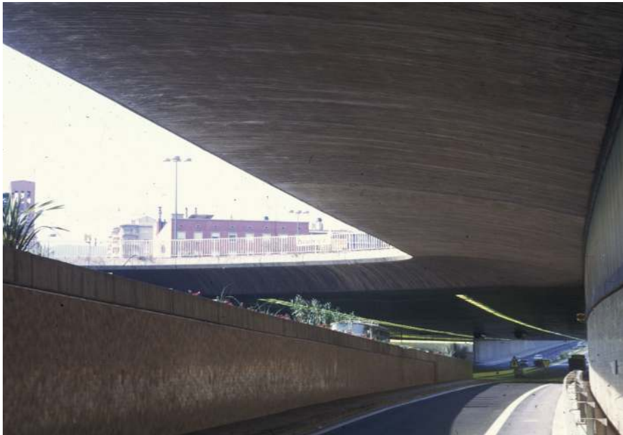
Paso bajo la Diagonal-Barcelona.
