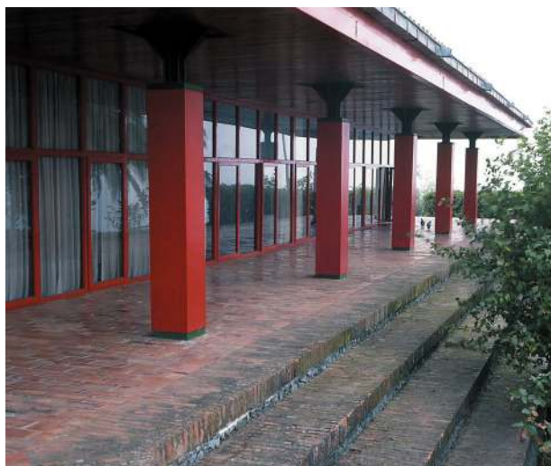
Capiteles metálicos en Imanolena.
