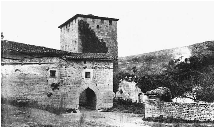
Vista de la puerta de acceso por el norte y Casa-Torre de los Velasco.
