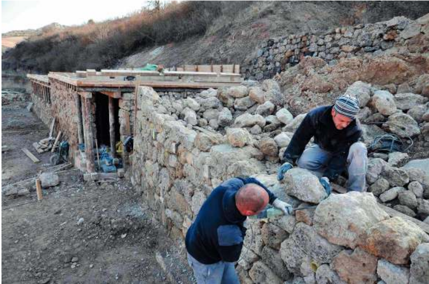
Restauración de la zona de la cabecera del Valle Salado
