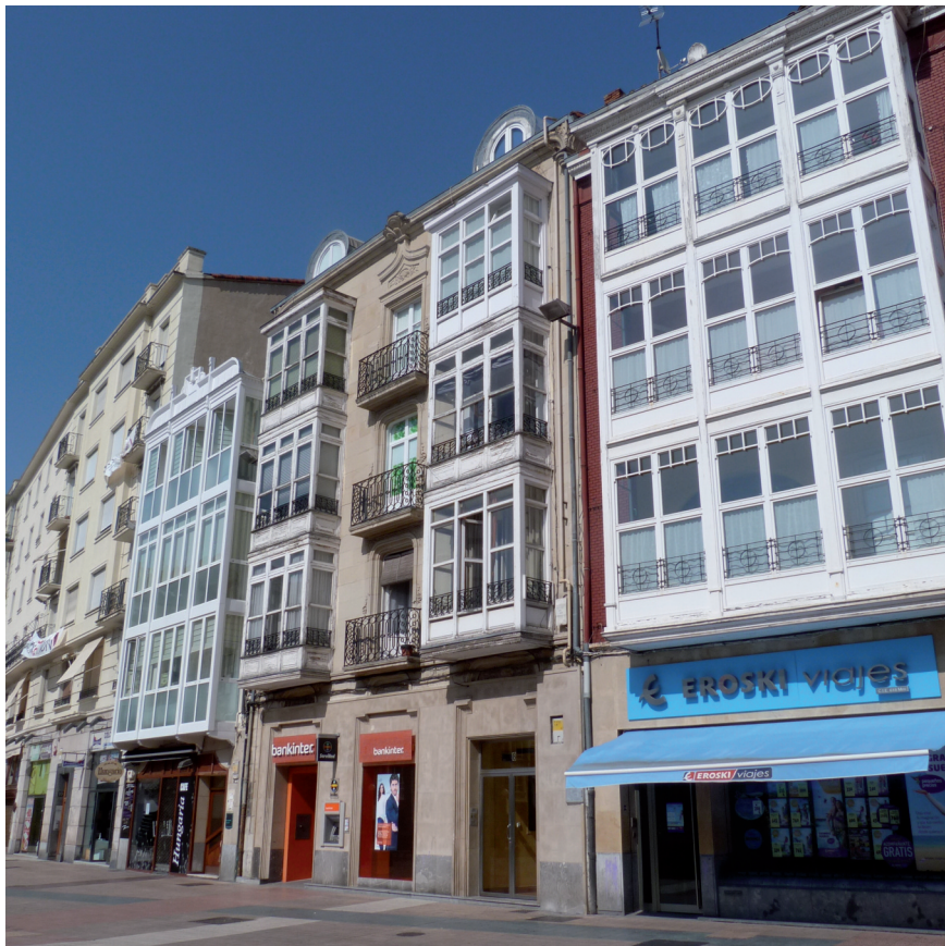
Edificio de viviendas plaza de la Provincia 8. Vista de conjunto
