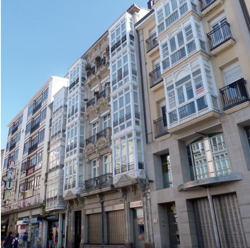
Edificio de viviendas, Postas 14. Vista de conjunto
