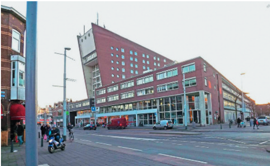
Foto nº 13. Edificio Berweg Humanitas. Rotterdam. https://www.stichtinghumanitas.nl/home/homepage/locaties/humanitas-berweg/
