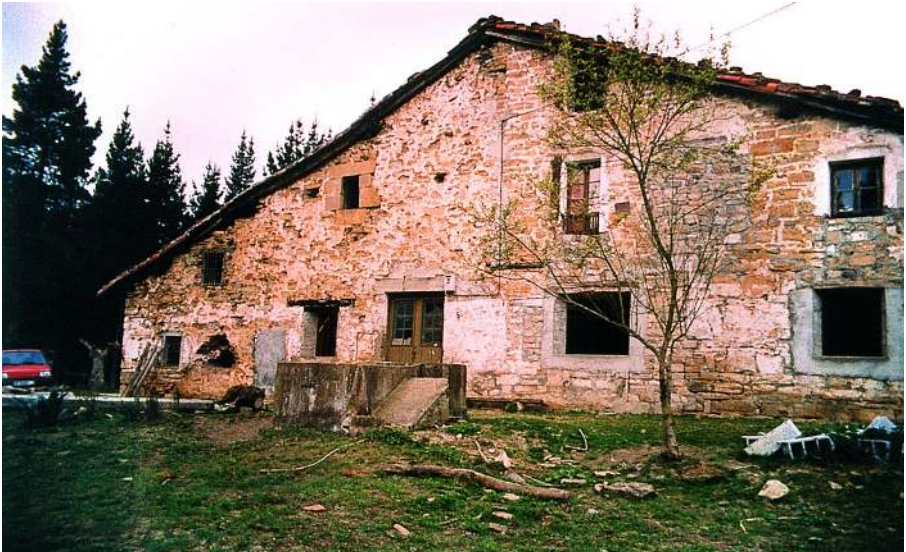
Figura 13. Lavadero de Caserío Amatiano. Bergara.
