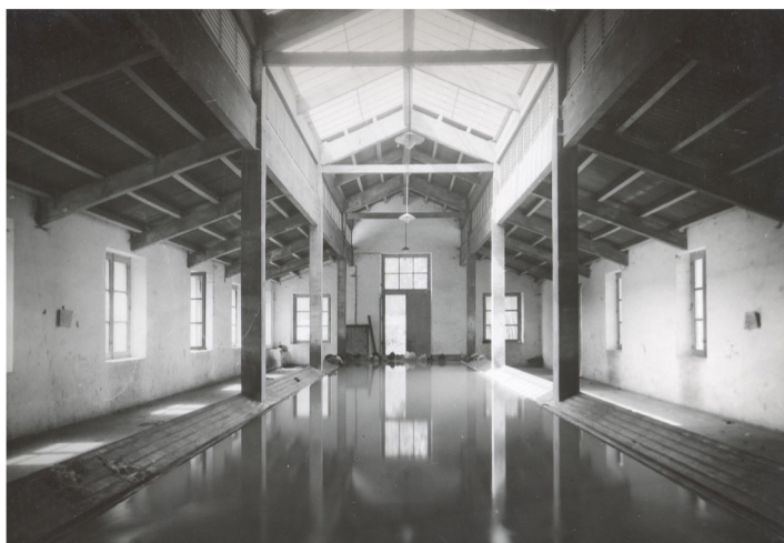
Figura 2.2. Interior del lavadero de la Rochapea. AMP, José Galle, 1938.
