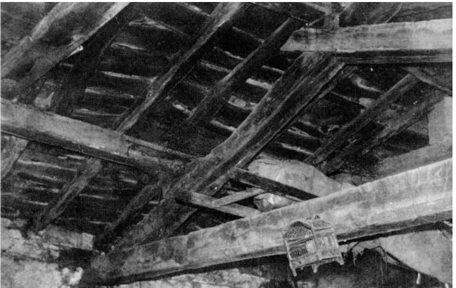
Foto 7.- Maderamen que sostiene en tijeras, las solivas de la techumbre del interior del molino.
