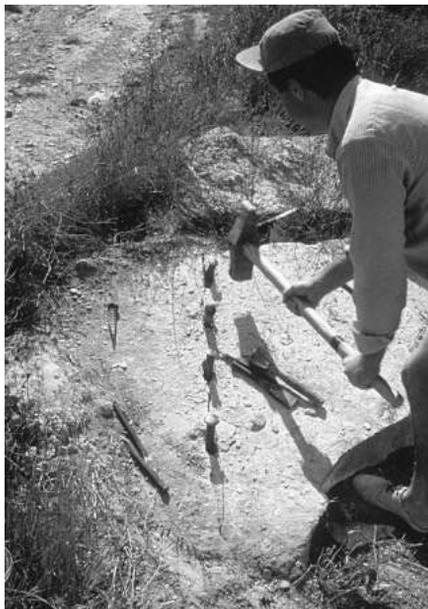
Fig. 5. Fractura de la pieza mediante percusión de mallo sobre las cuñas ya dispuestas.
