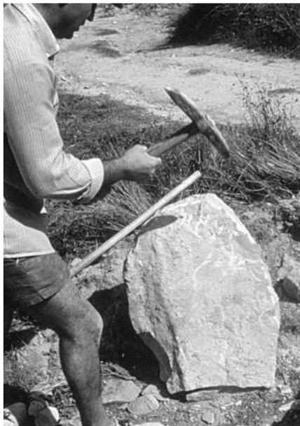
Fig. 6. Desbaste de la pieza mediante uso de escoda.
