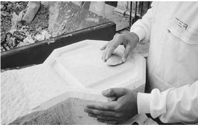
Fig. 25. Elaboración de la pieza 2. Pulido de la cara b mediante abrasión de un fragmento de piedra del mismo tipo que el de la pieza.
