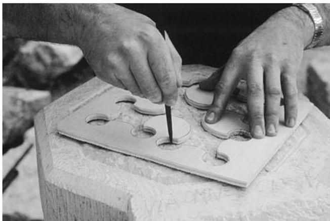
Fig. 22. Elaboración de la pieza 2. Marcado de la figura decorativa mediante plantilla y punzón.
