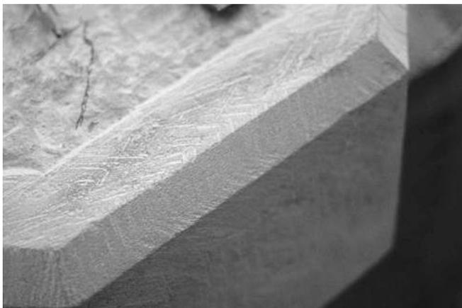
Fig. 21. Elaboración de la pieza 2. Vista del chafán o moldura, pulido por fricción del cincel.
