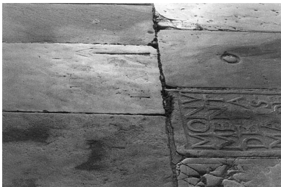
Fot. nº 1. Losas que forman el pavimento del atrio de la iglesia parroquial de Bidarte (Lapurdi). Entre ellas se encuentra la que presenta un arpón. Cliché: Fermín de Leizaola 300891.
