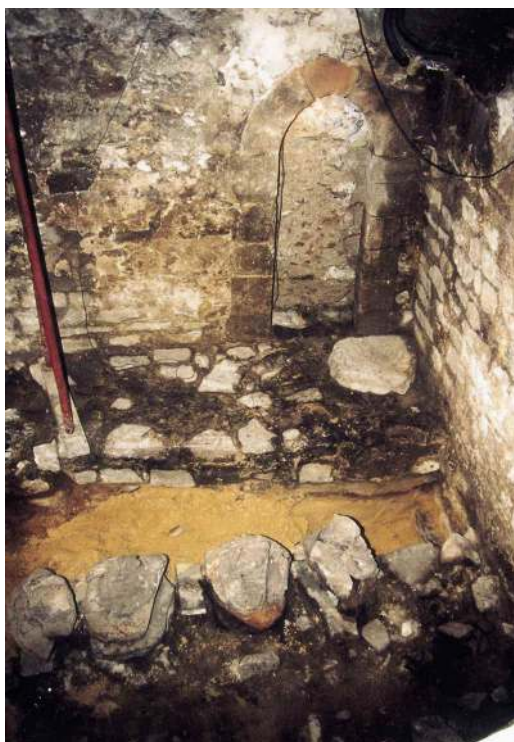
Foto nº 2: Vista general del acceso en forma de arco ligeramente apuntado abierto en el medianil W.
