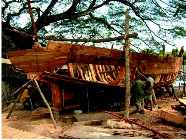
Fig. 13. Colocación del forro (foto, Asier Iñarra).
