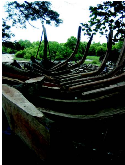
Fig. 12. Colocación de las cuadernas.
