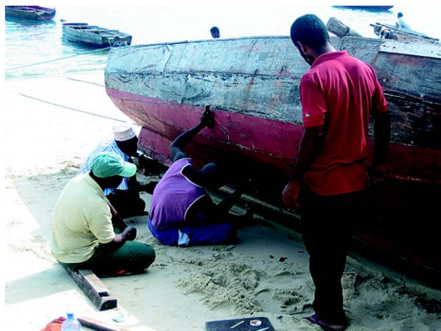
Fig. 15. Reparación del casco.
