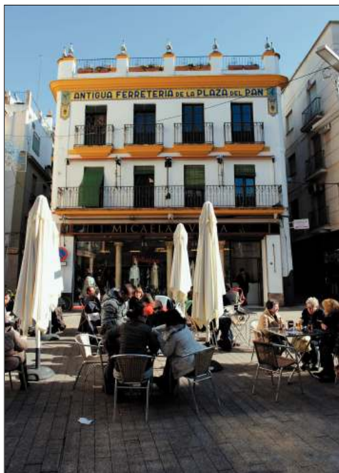
Fig. 1. Vista lateral del Edificio de la Ferretería, en la Plaza del Pan.
