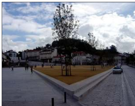
O espaço não foi pensado para pessoas com handicaps. O muro é todo feito em arestas vivas.
