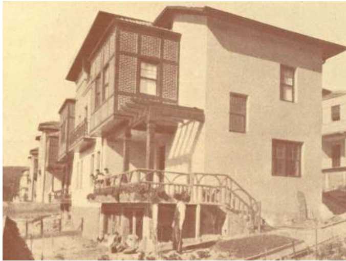
Fig. 10. Ciudad Jardín (1923-8) Pedro de Ispizua. Imagen publicada en: La Excm. Diputación de Vizcaya y el problema de la vivienda . Bilbao: Imprenta, lit., relieves Jesús Álvarez, [s.a.], p. 43.
