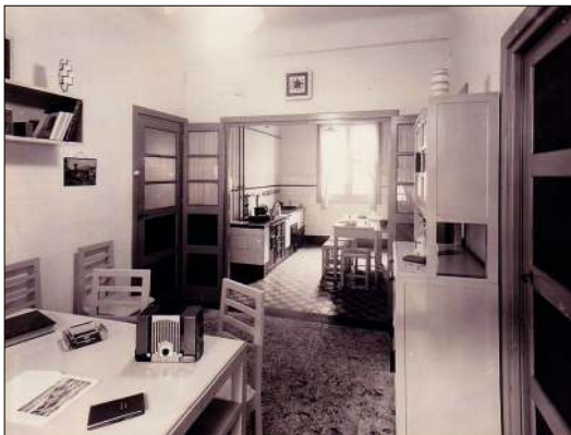
Fig. 15. Cocina-comedor de las viviendas de Solocoeche (1932-1933) Emiliano Amann. Archivo de Viviendas Municipales de Bilbao.
