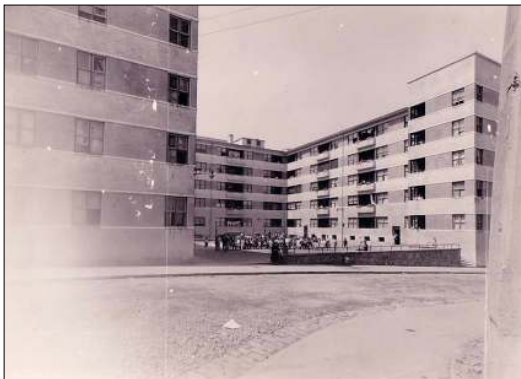
Fig. 13. Viviendas municipales de Solocoeche (1932-1933) Emiliano Amann. Archivo de Viviendas Municipales de Bilbao.
