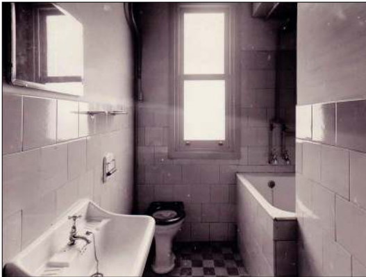
Fig. 16. Baño de las viviendas de Solocoeche (1932-1933) Emiliano Amann. Archivo de Viviendas Municipales de Bilbao.
