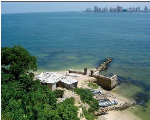
Hacienda de San Bernabé, siglo XVII, parcialmente sumergida en las costas de Tierra Bomba. Archivo Fundación Terra Firme, 2009.
