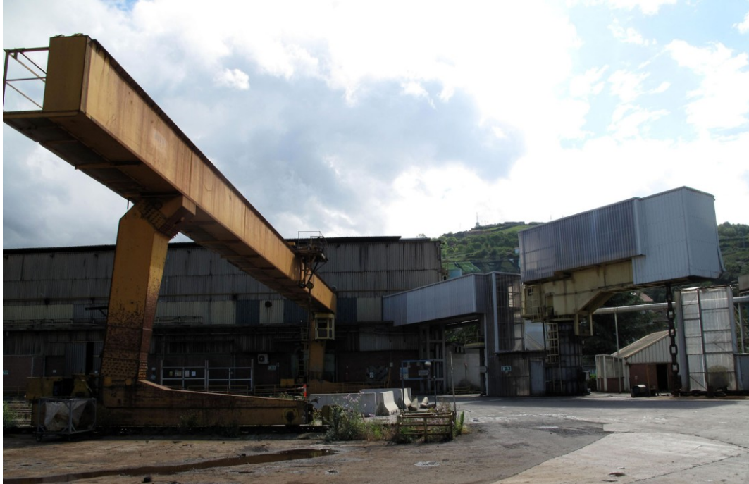
Figura 16 Interiores en desmontaje de la fábrica "Vicinay Cadenas" durante la primavera del año 2016
