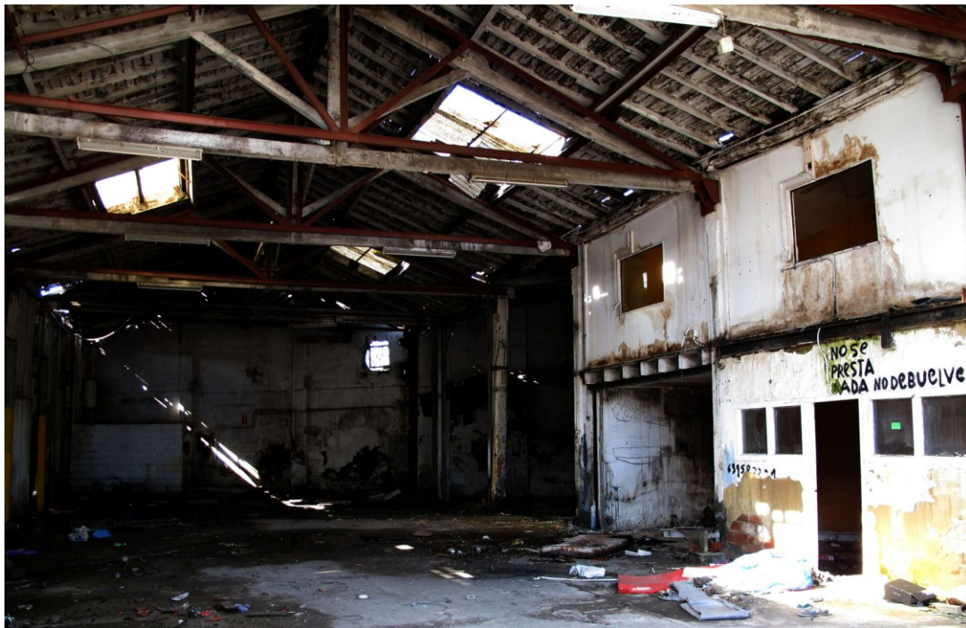
Figura 17 Oscuros pabellones industriales en fase de vaciamiento interior, aunque a veces habitados (primavera 2018)
