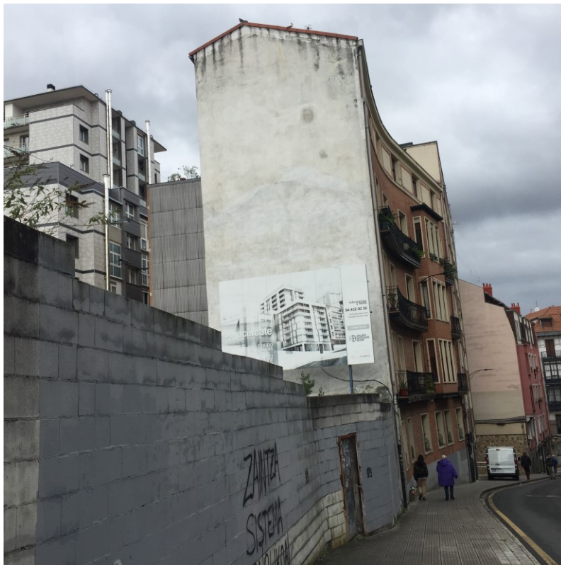
Figura 12 Muro construido, correspondiente a posteriores intervenciones urbanísticas (calle Zabalbide, 2022)
