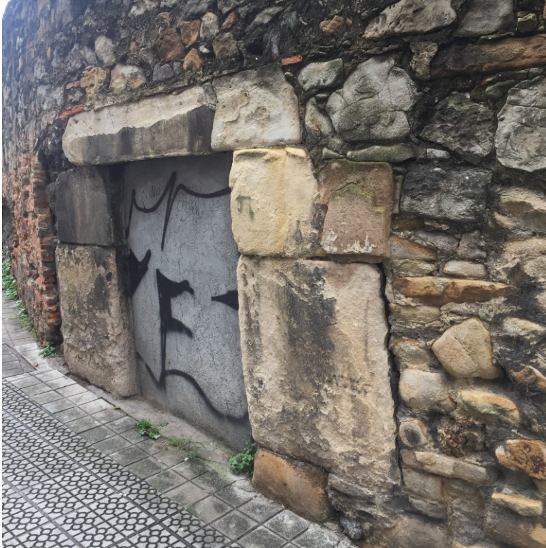
Figura 15 Puerta del muro, tapiada y grafitada (calle Zabalbide, 2023)
