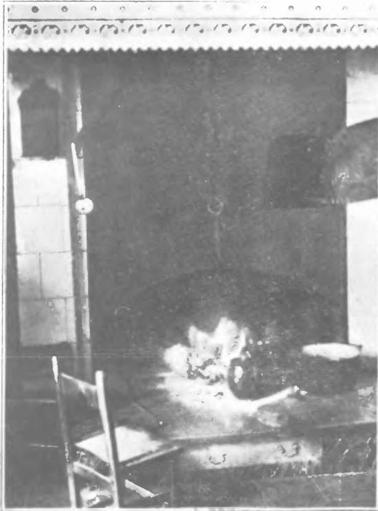
*Fot. n.º 16.*—Fogón de la casa *lñārea* (Burguete). En el fondo se ve la boca del *txakurtegi*. A la izquierda, junto a la pared, se ve una vigueta vertical giratoria, de cuyo extremo superior arranca un brazo de donde cuelga el llar. Arriba a la derecha, la boca del horno.
