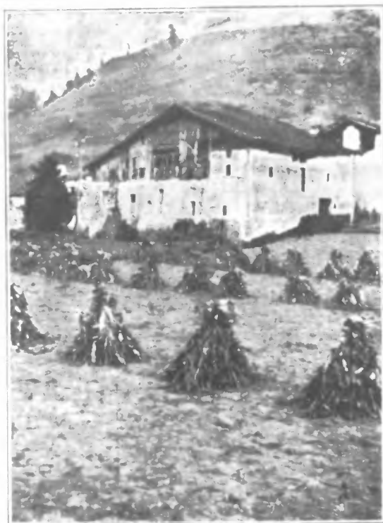
Caserío Arzulo: parte lateral y zaguera.
