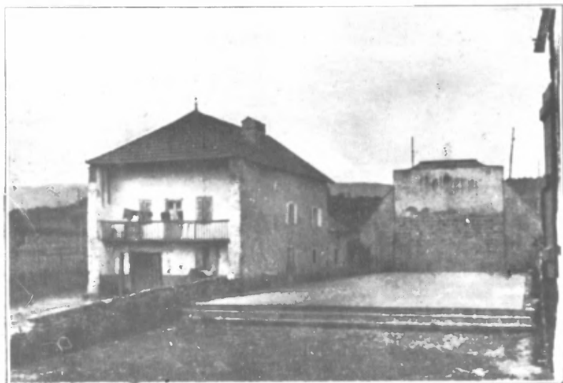
Fot. n.º 1. —Casa Kaxton : fachada principal con fraileak o espigones a los lados; cubierta de teja plana. A la derecha, el frontón para el juego de pelota.
