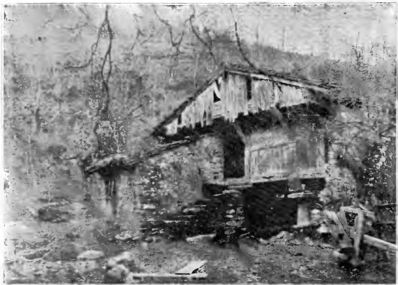
Fig. 5.—Garaixe del caserío Otzabarena (barrio Aldape—Elorrio).
