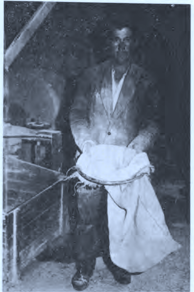
Fig. 11.—Modo de colocar el aro, para que la boca del saco quede abierta.
