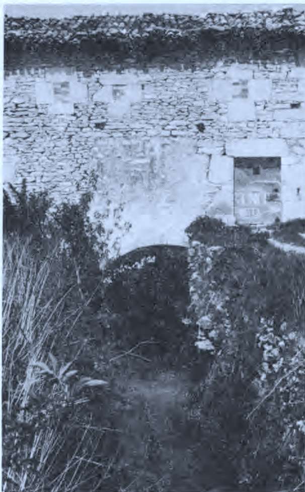
Fig. 7. — Edificio del molino. Fot. Lz. de Guereñu.
