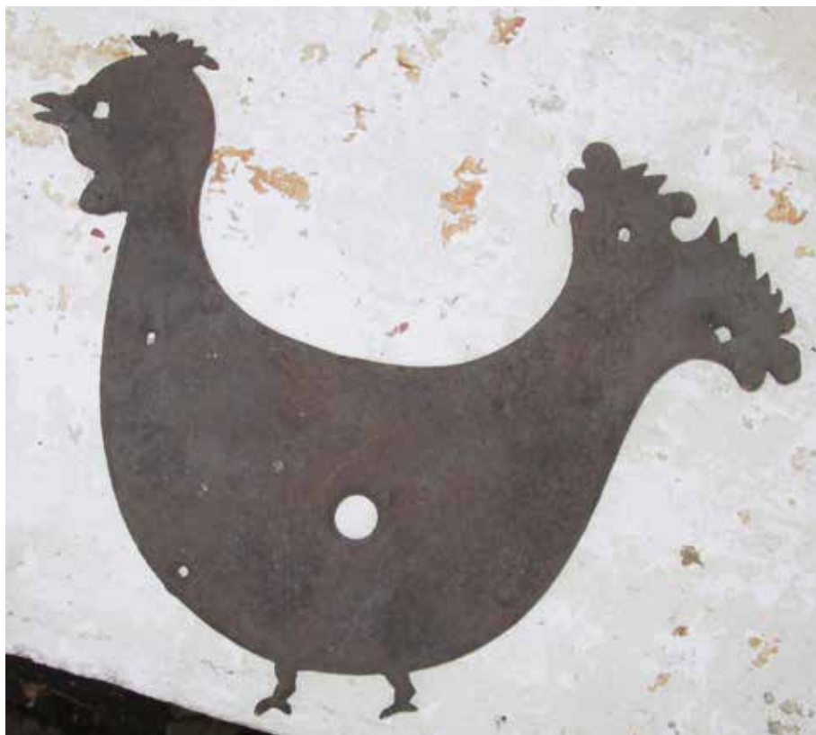
Fig. 9: garniture de loquet de porte, la poignée actionnait le pêne en passant dans le trou au milieu du corps de l'animal.
