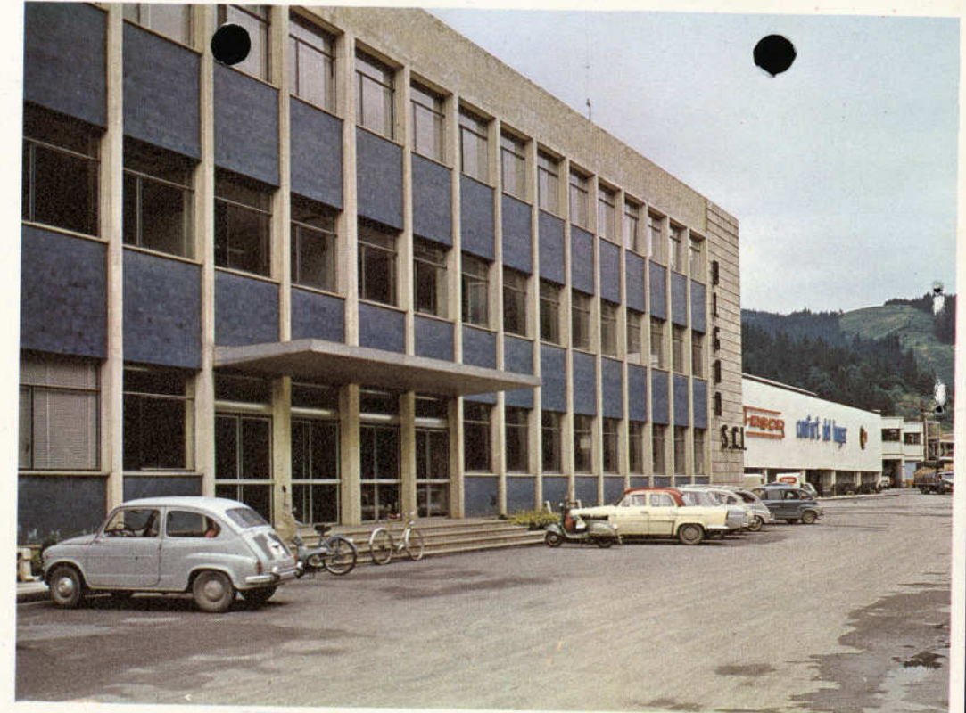
Vista parcial de la entrada al edificio representativo.
