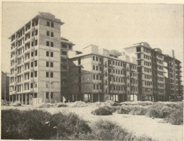
MURCIA. Viviendas cooperativas en construcción
