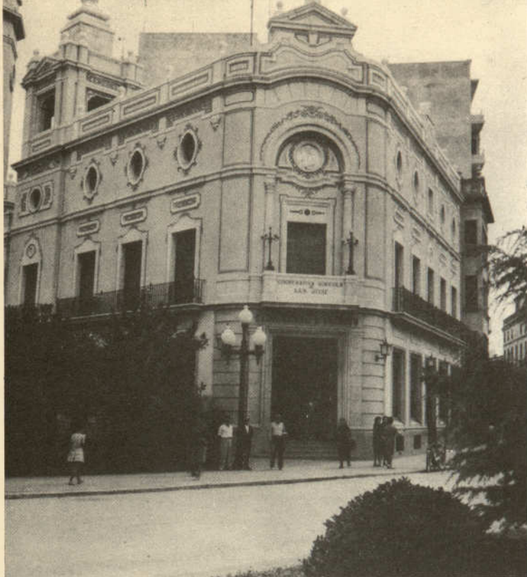
ALMAZORA (Castellón). Edificio de la Cooperativa Agrícola "San José"
