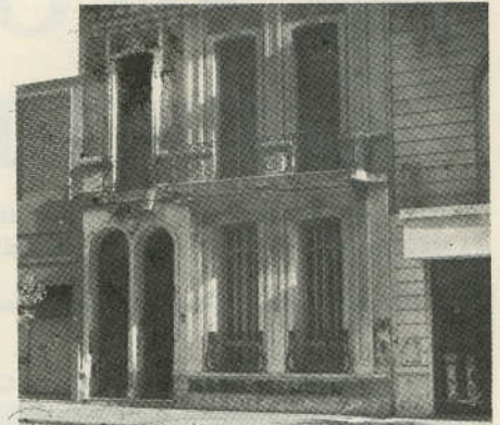
Una vista que se pierde: la sede del Coro Lagun Onak, en la avenida Córdoba 3476
