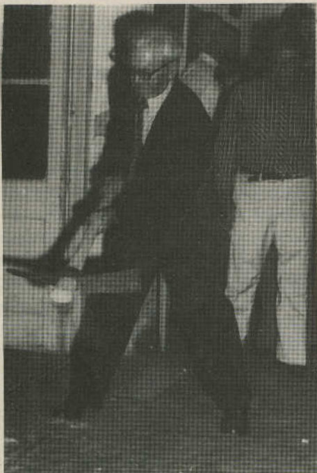
Julián bilbao, en un acto simbólico de demolición del antiguo edificio del Centro Lagun Onak de Pergamino
