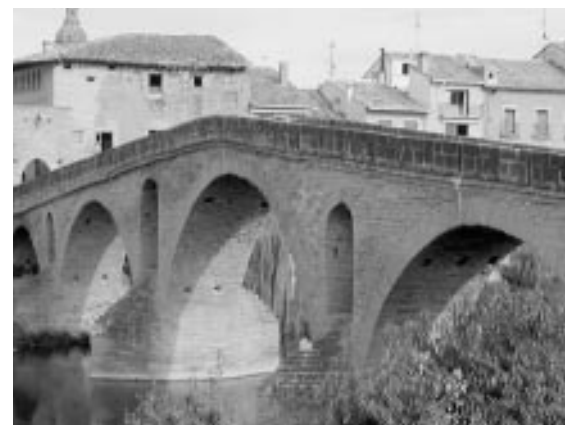
Puente La Reina (Camino Santiago).
